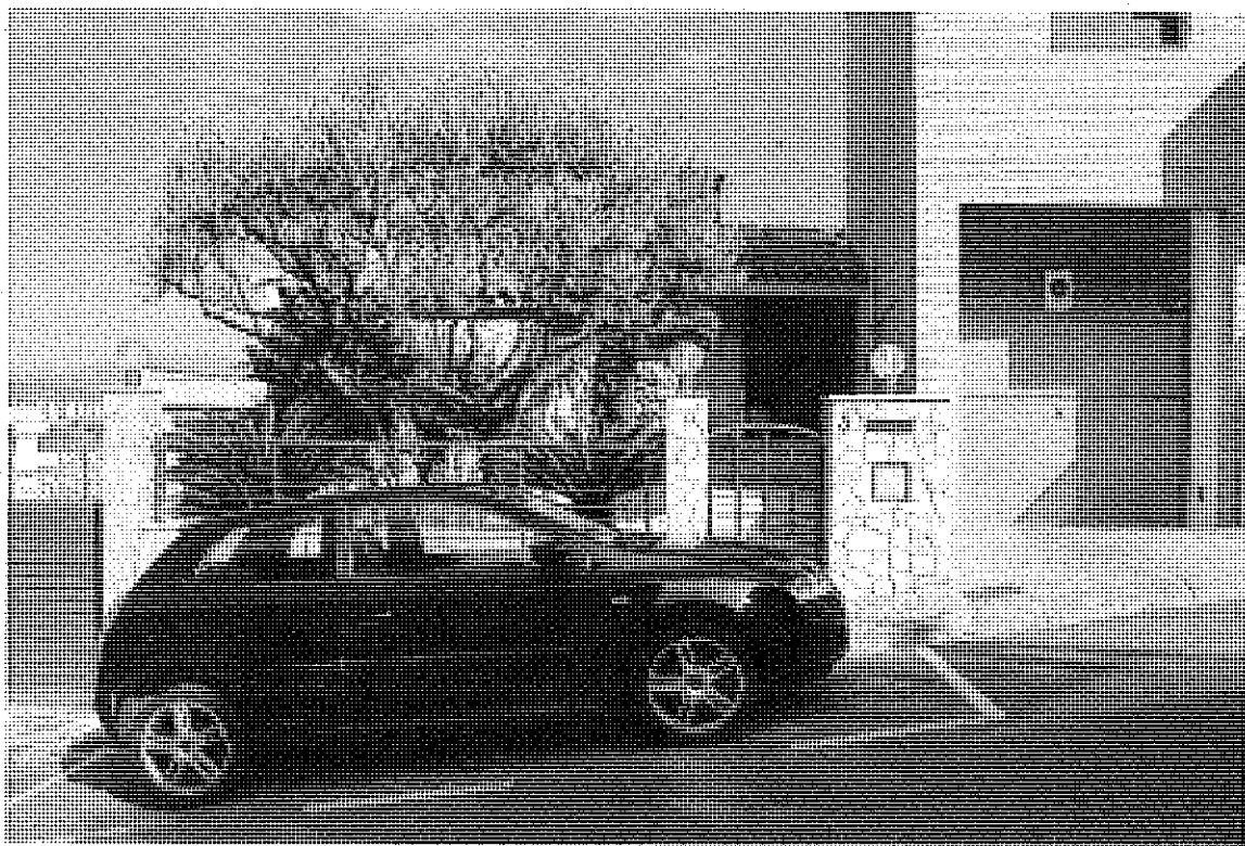
Finca situada en el Paseo de Santa Bàrbara número 1, adosada al edificio plurifamiliar colindante, situado en el Paseo de Santa Bàrbara número 5.
