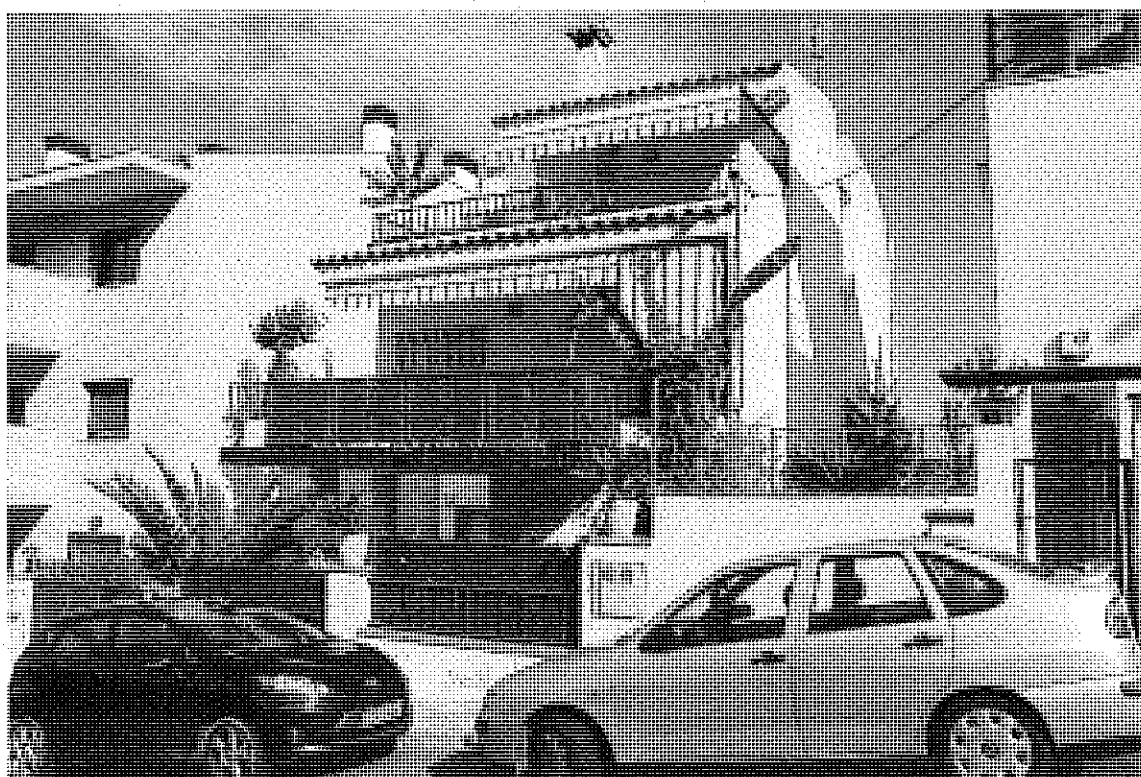
Edificación situada en el Paseo de Santa Bárbara número 7, adosada a el límite de la parcela situada en el Paseo de Santa Bárbara número 9.
